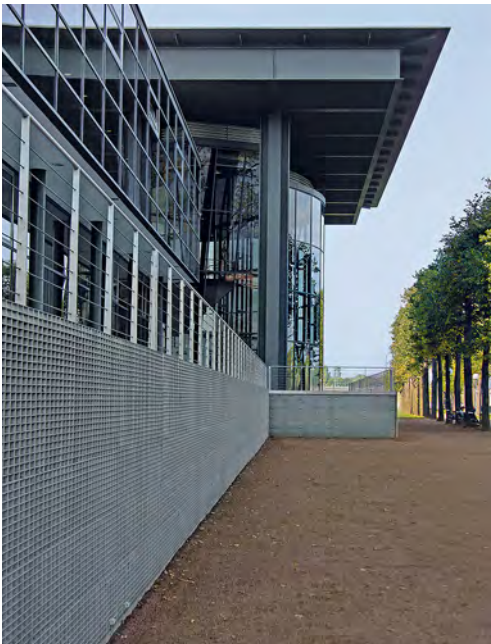
Saxonyn osavaltion parlamenttirakennuksen Elbe-jokea reunustavat betoniperustukset on verhoiltu ritilöillä (Dresden, Saksa).
