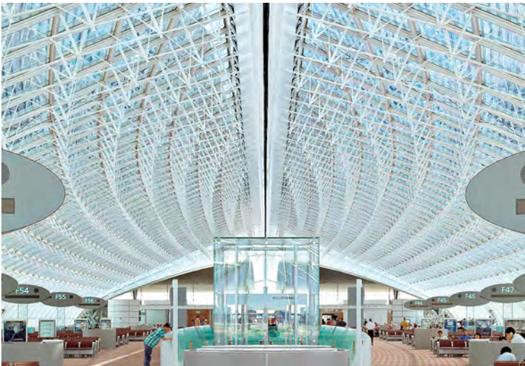
Profiloitu, 68 mm aukoilla rei'itetty ruostumaton teräslevy suojaa Charles de Gaulle – lentokentän lasitetun lähtöaulan sisätiloja auringonvalolta (Pariisi, Ranska).
