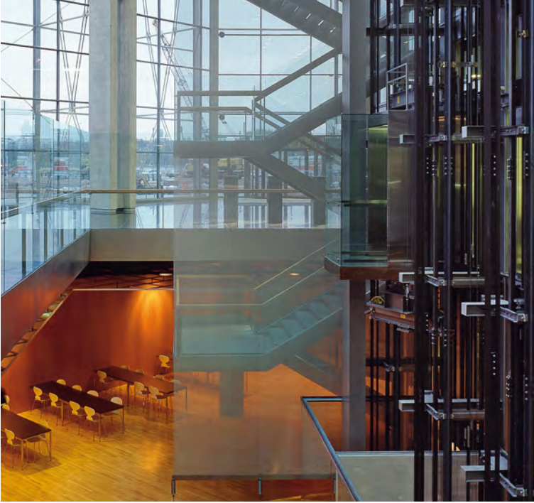
Metallikankaasta valmistettu rakenne toimii Sanomatalon yhdeksänkerroksisen porraskäytävän suojakaiteena (Helsinki, Suomi).
