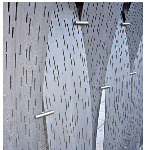
Kaarevat ruostumattomat teräslevyt, jotka on perforoitu epäsäännöllisillä, laserleikatuilla aukoilla, rajoittavat Karlplatzin poliisiaseman edustan näkyvyyttä (Wien, Itävalta).
