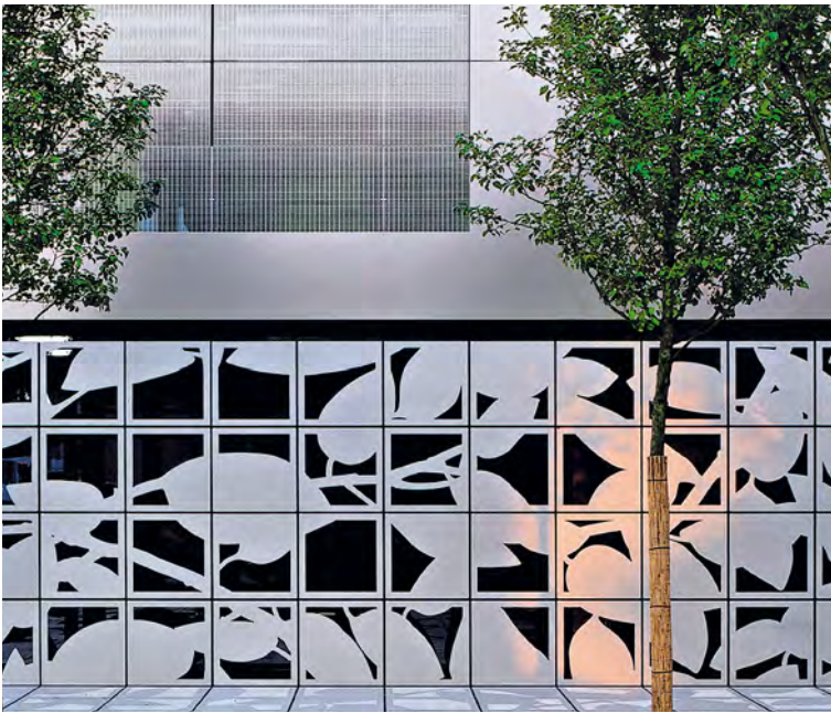
Hallintorakennuksen pohjakerroksen seinustaa koristaa 3 metriä korkea, 5 mm paksuun ruostumattomaan teräslevyn laserleikattu kukkakuvio (Reutlingen, Saksa).
