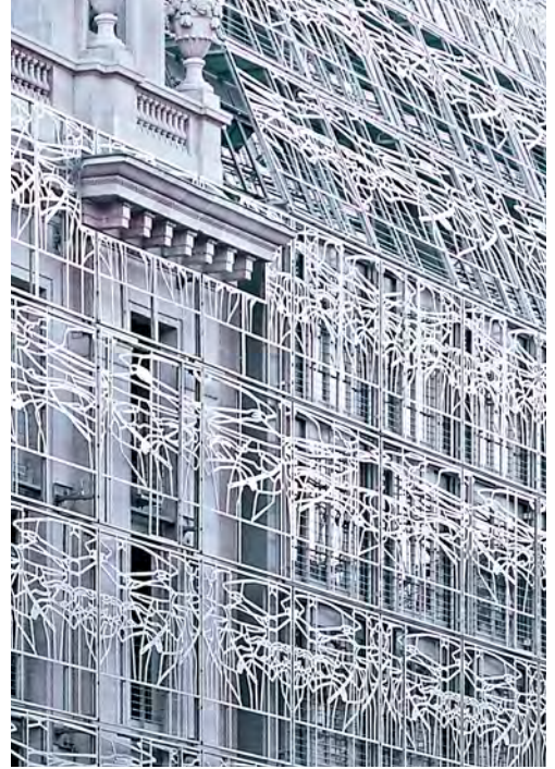
Kulttuuriministeriön ulkoseiniä koristaa 12 mm paksusta ruostumattomasta teräslevystä laserleikattu verhoilu (Pariisi, Ranska).
