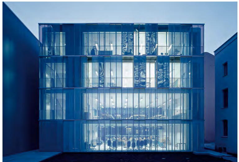
Sisätilojen monikäyttöisyys heijastuu myös rakennuksen muuntuvaan julkisivuun. Valon määrää sekä rakennuksen ulkonäköä voidaan säädellä halutuksi limitäisten levyverkko-elementtien sijaintia muuttamalla.
